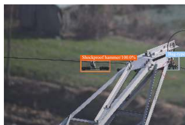
(b) 嵌入遮挡关系模块后 SSD 模型金具正确检测结果
